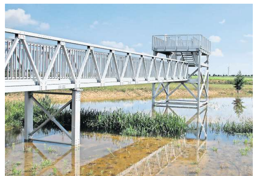
Ein Turm mitten in der Landschaft: 33,5 Meter lang, 8 Tonnen schwer, 5 Meter hoch. Im Oktober 2019 wurde das Bauwerk aus vorgefertigten Teilen errichtet.
